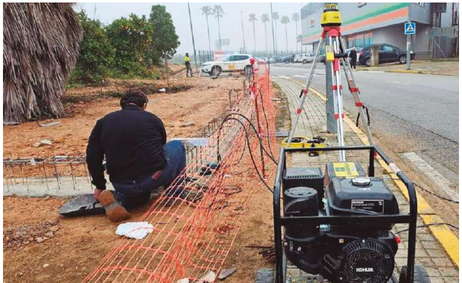
Operario instalando el nuevo vallado.
