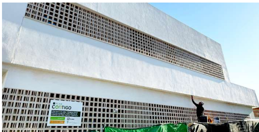
Las obras se ejecutarán hasta final de año.
