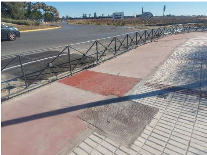
Punto de conexión a red general de Aljarafesa.
